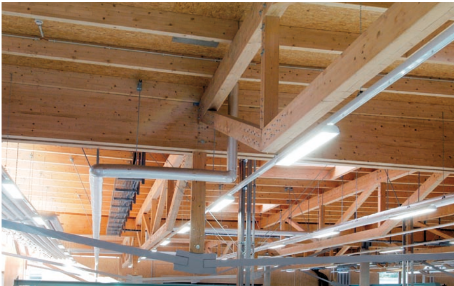
Die Dachkonstruktion besteht aus Hauptträgern, die mit Stahlgurten unterspannt sind. Quer dazu liegen Fachwerkbinder zwischen den Hauptträgern.
