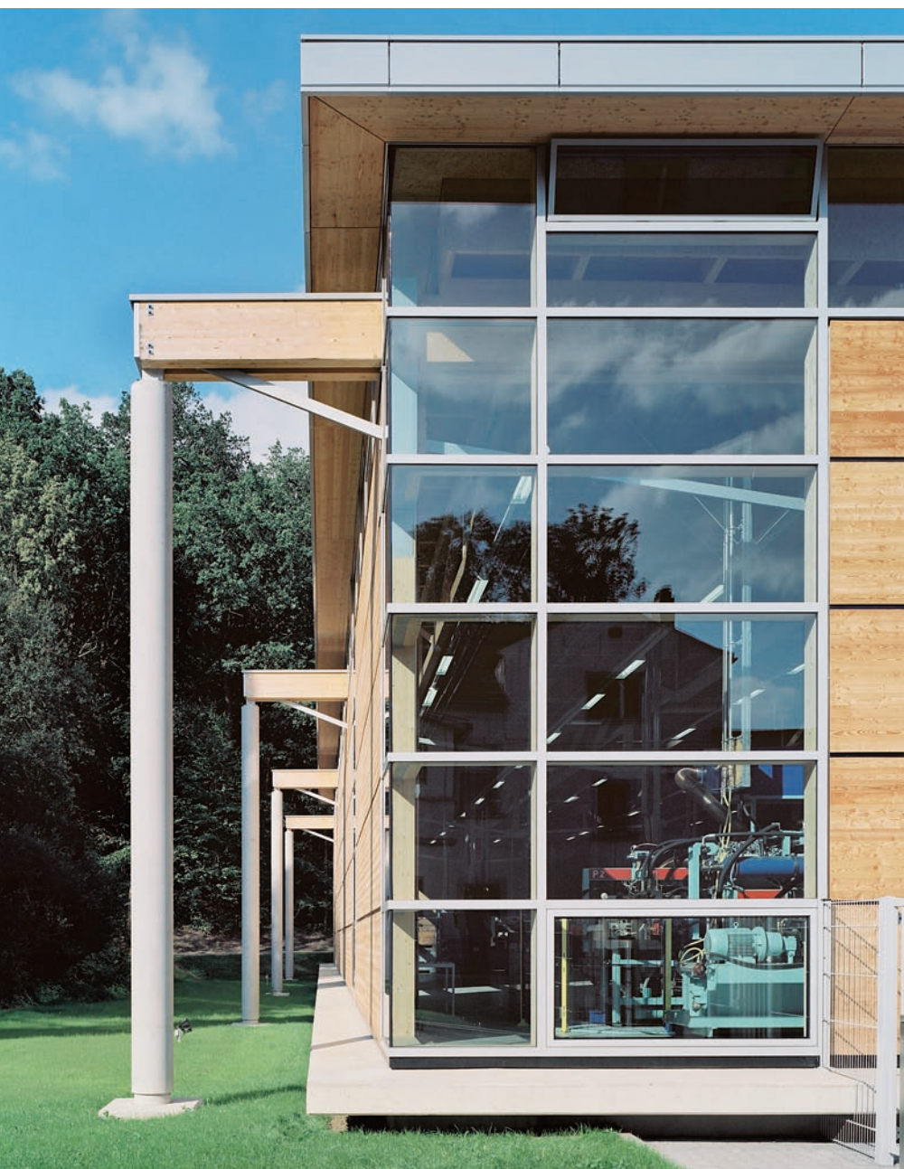
Die Hauptträger liegen auf Stahlbetonfertigstützen auf und sind mittels Stahlknotenblechen mit ihnen verbunden.
